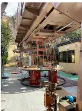
・工事の様子
