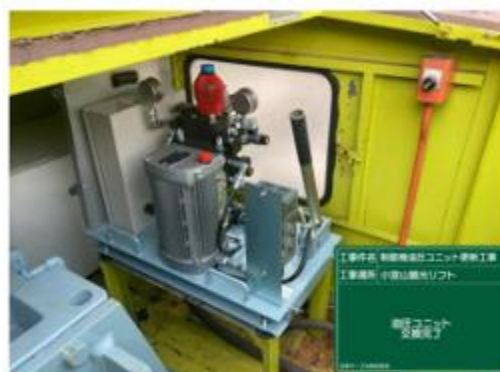
・制動機油圧ユニット更新
