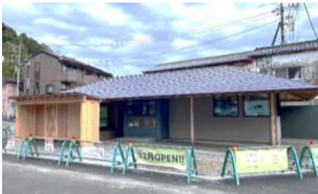
施設外観（施工中の様子）
