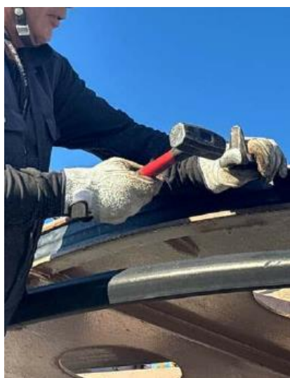
・ゴムライナー溝の消耗による亀裂に伴う整備
